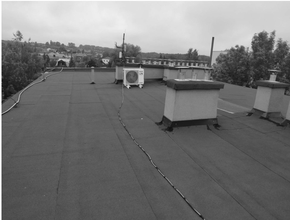
Fot. Widok dachu
