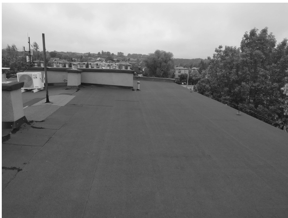
Fot. Widok dachu
