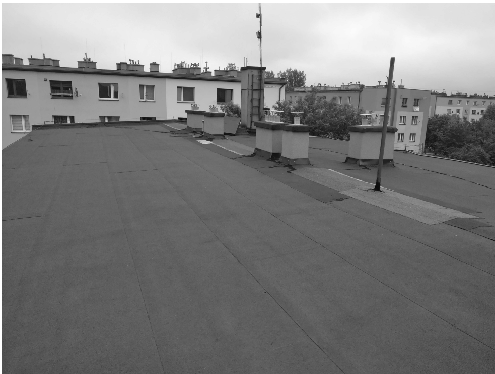
Fot. Widok dachu
